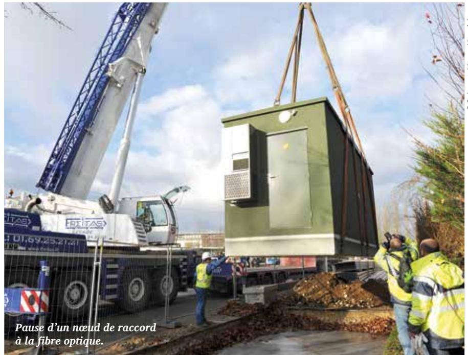
*Pause d'un nœud de raccord à la fibre optique.*
