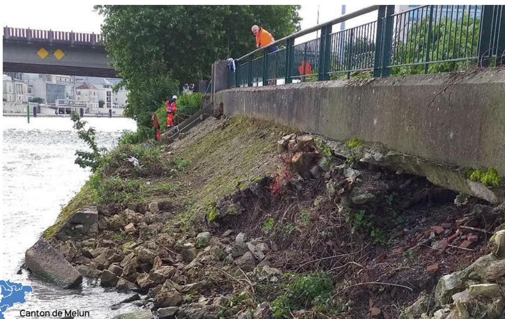
Jusqu'au 6 décembre, le Département effectue des travaux, pour un montant de 240 000 €, quai Hippolyte Rossignol à Melun. L'ouvrage, qui soutient la RD376 et permet le libre écoulement des eaux de la Seine, a subi des dégradations liées à l'usure du temps : déchaussement des pierres situées sur les parties humides et immergées, affaissement du trottoir...
