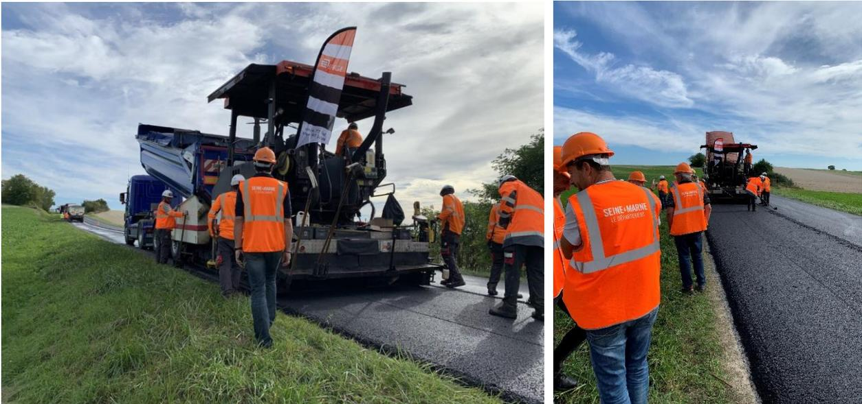
Développé par l'entreprise Eiffage Route, l'enrobé HPE permet d'améliorer la revalorisation des matériaux de déconstruction (routière, ferroviaire, bâtiment) ; il peut contenir **de 40 % à plus de 80 % de matériaux recyclés** (élaborés à partir d'anciennes routes, de bétons de déconstruction ou du ballast du réseau ferré).
