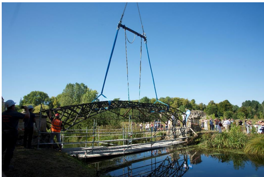
Levage du pont © Alexis Harnichard
