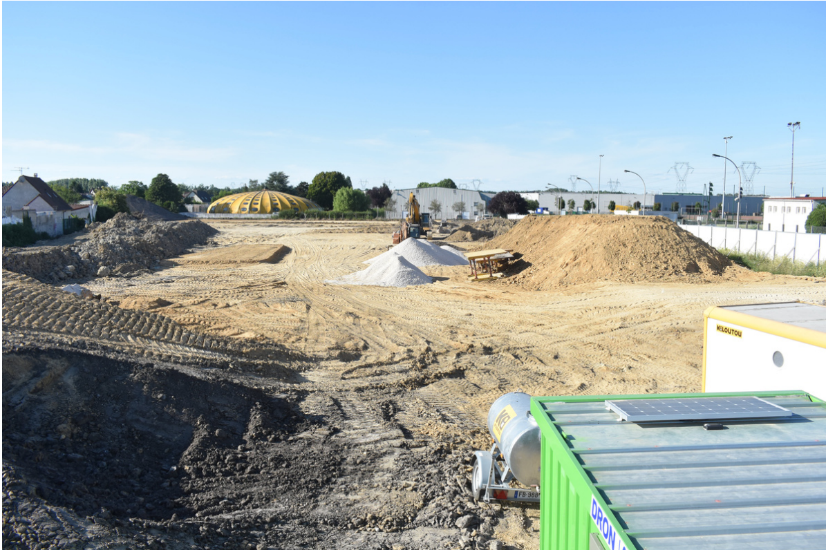
Avancement du chantier au 1er juin 2020
