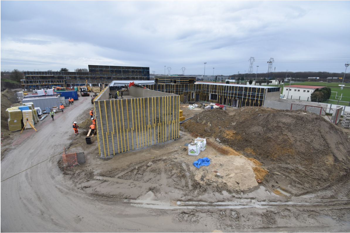
Avancement du chantier au 18 février 2021
