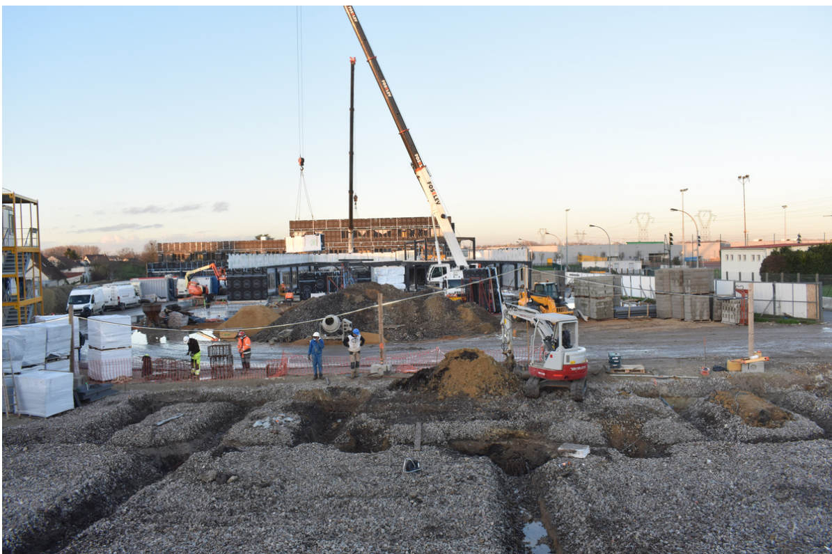
Avancement du chantier au 15 décembre 2020
