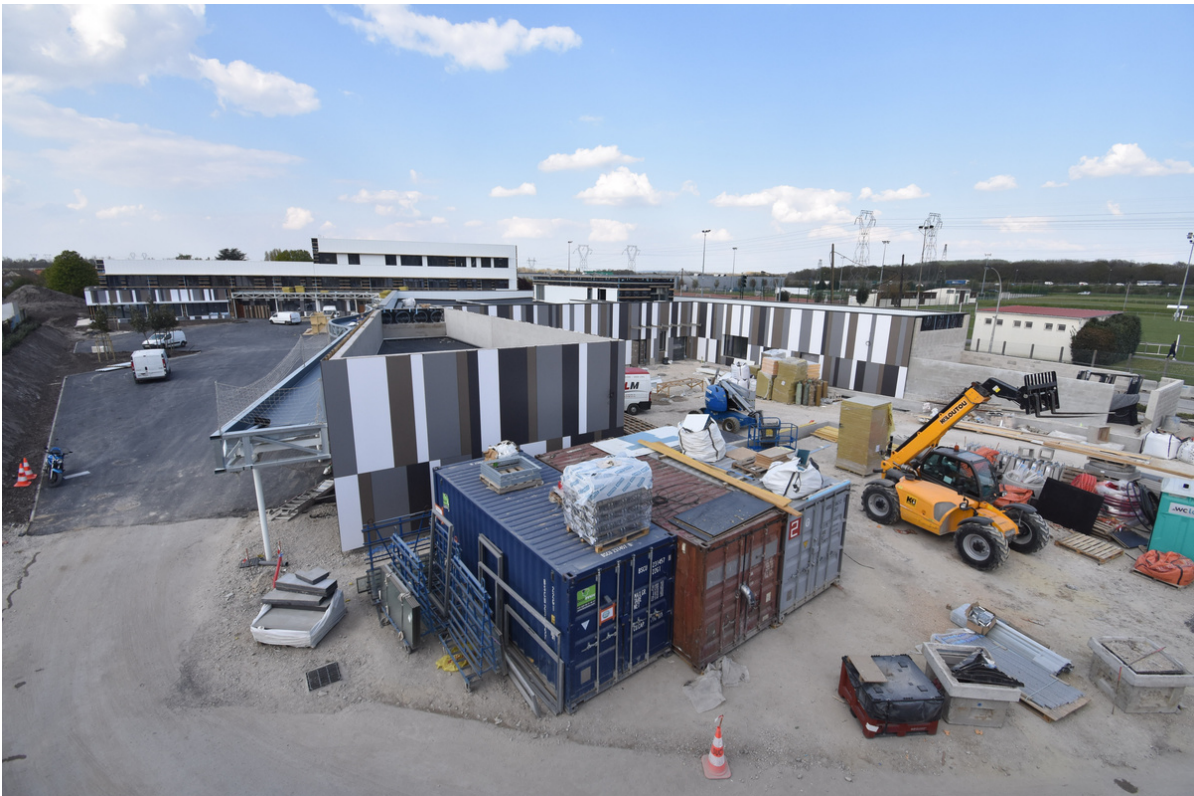
Avancement du chantier au 20 avril 2021
