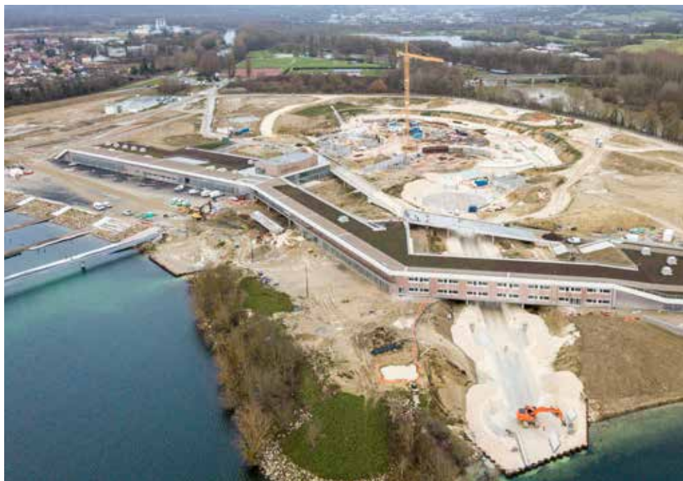
Vue aérienne du chantier de la base nautique de Vaires-sur-Marne pour les Jeux Olympiques Paris 2024
