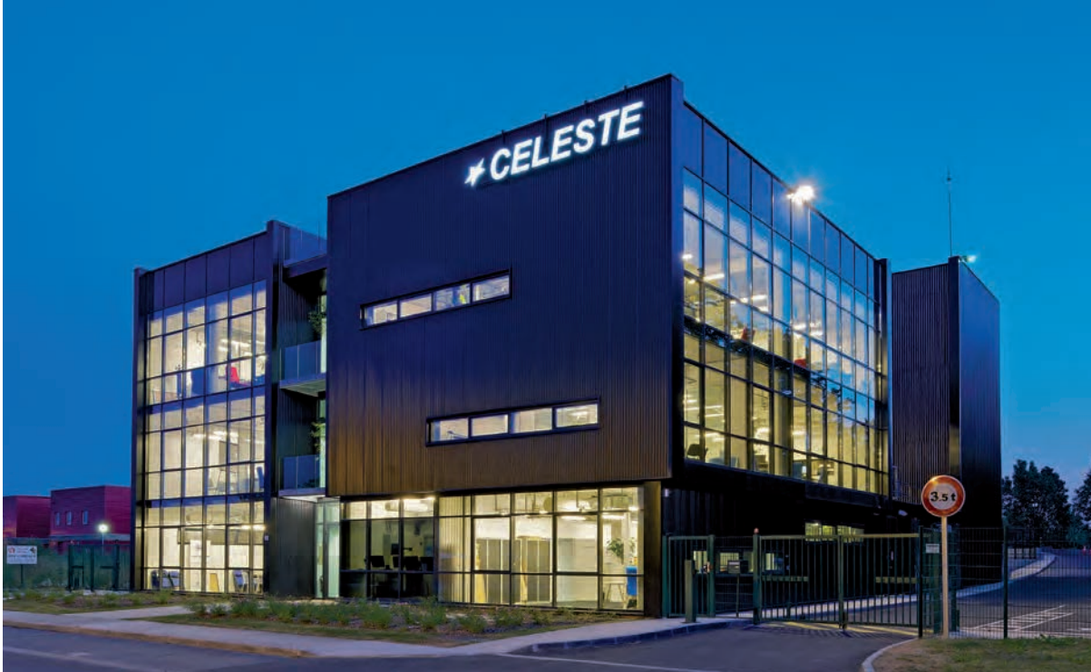
Le data center de Champs-sur-Marne est le premier centre de données écologique et haute-densité au monde.
