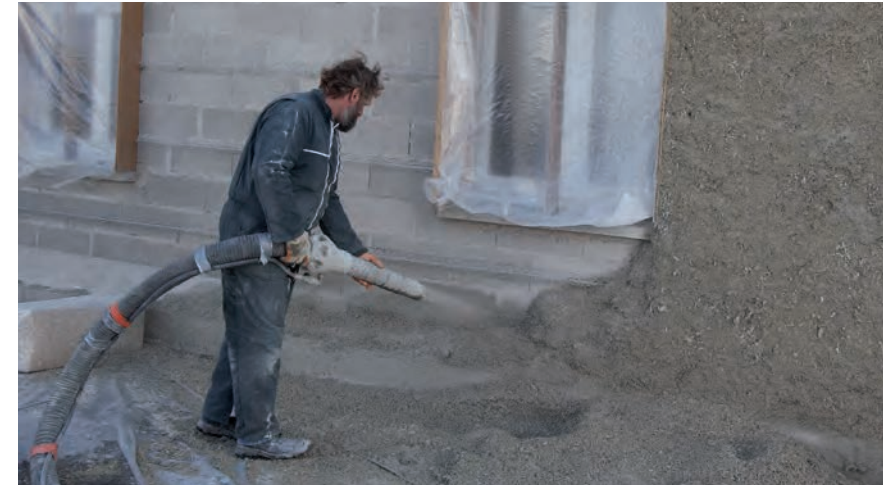
Les agro-matériaux sont une opportunité de valoriser les ressources agricoles et de créer de l'emploi local. Ici, le chanvre est utilisé en matériau de construction.
