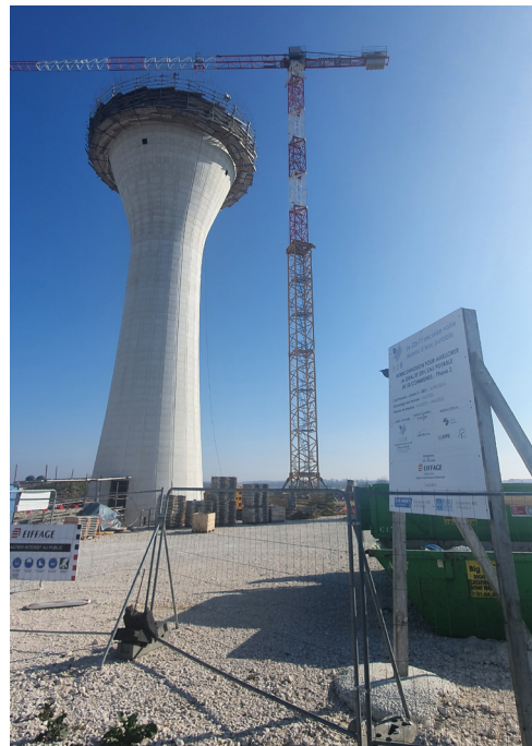
Construction du château d'eau de Courtacon par le S2E77 dans le cadre du projet d'interconnexion du Transpr'eauinois financé à 30 % par le Département.
